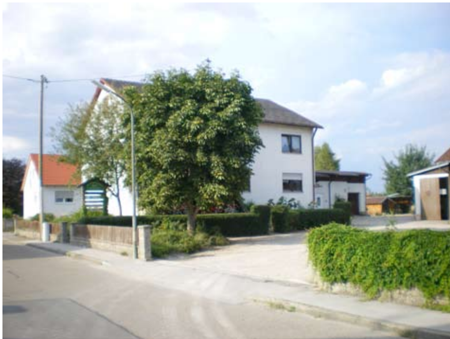
Der Neubau des Wohnhauses des Hofes. Foto: : Dr. Hans Perlinger, 2008.
