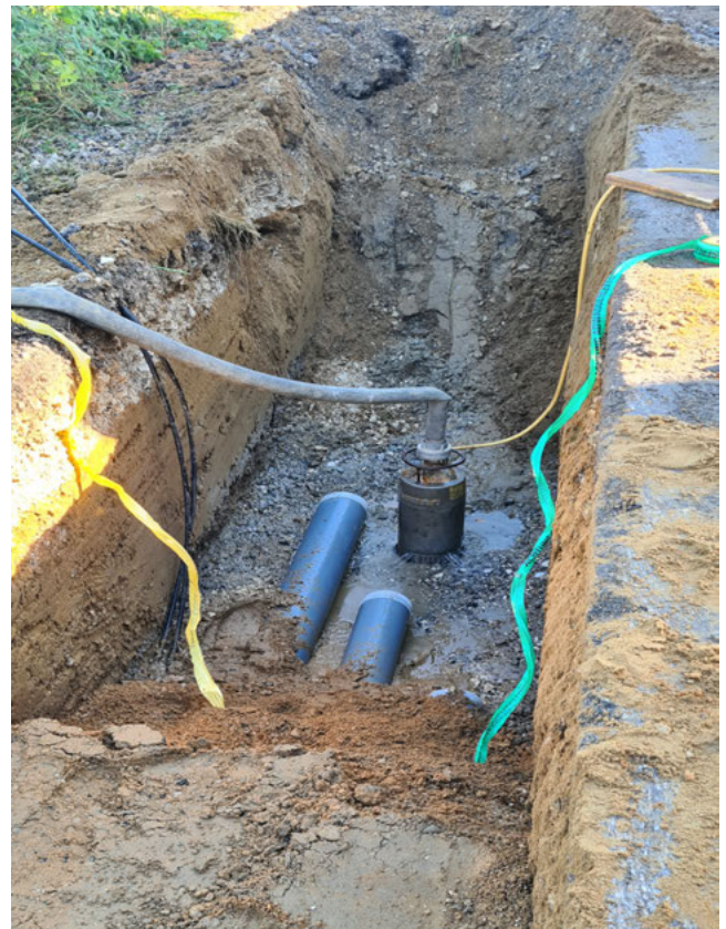
Neubau der Vakuumleitung zum Josephenburger Weiher
