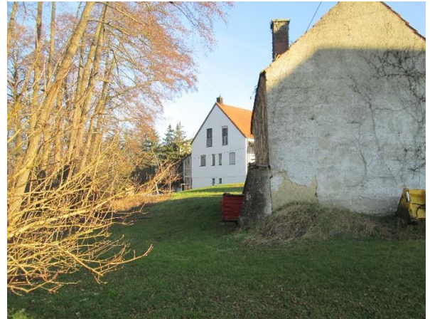
Abbildung 10: Blick Richtung Westen auf das UG. (Aufnahmedatum 13.01.25)
