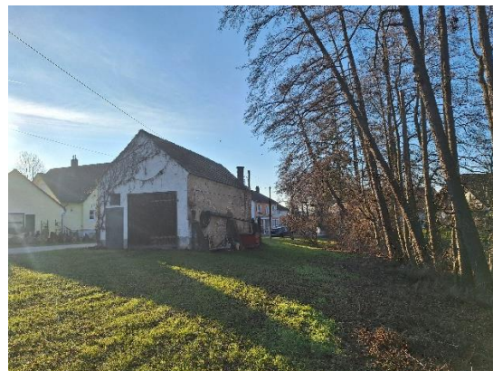
Abbildung 5: Blick von Nordosten auf das Grundstück und die bestehende Scheune, Gehölze entlang des Bachlaufs rechts, WipflerPLAN 13.01.2025
