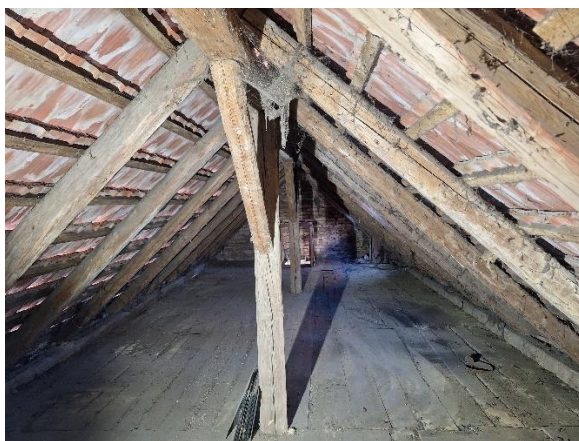
Abbildung 17: Dachboden des Bestandsgebäudes (Aufnah- medatum 19.02.25)
