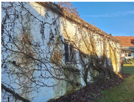
Abbildung 13: Südseite des Bestandsgebäudes mit Wein (Aufnahmedatum 13.01.25)
