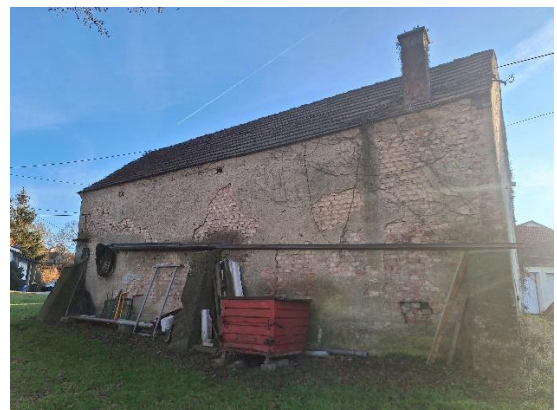
Abbildung 14: Nordseite des Bestandsgebäudes (Aufnahmedatum 13.01.25)
