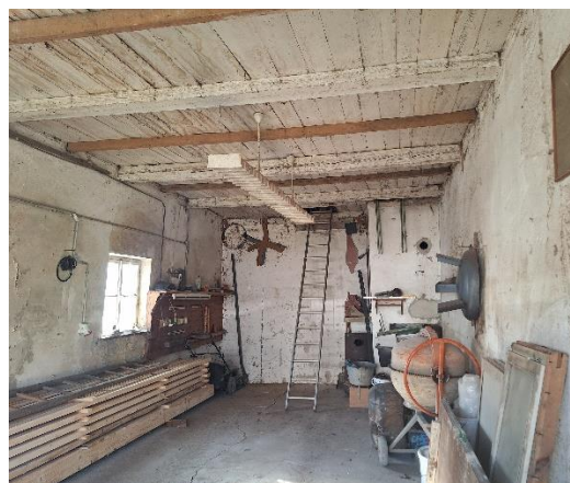
Abbildung 18: Erdgeschoss des Bestandsgebäudes (Aufnahmedatum 19.02.25)
