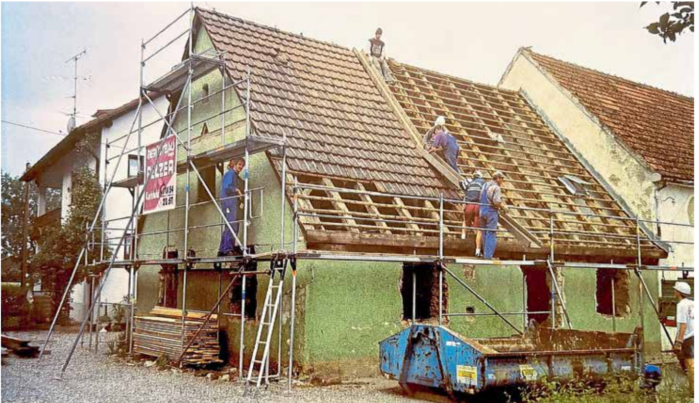
Abbau des Dachstuhls in Rosing
