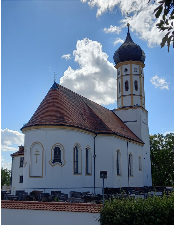
Pfarrkirche „Mariä Heimsuchung“ von aussen
